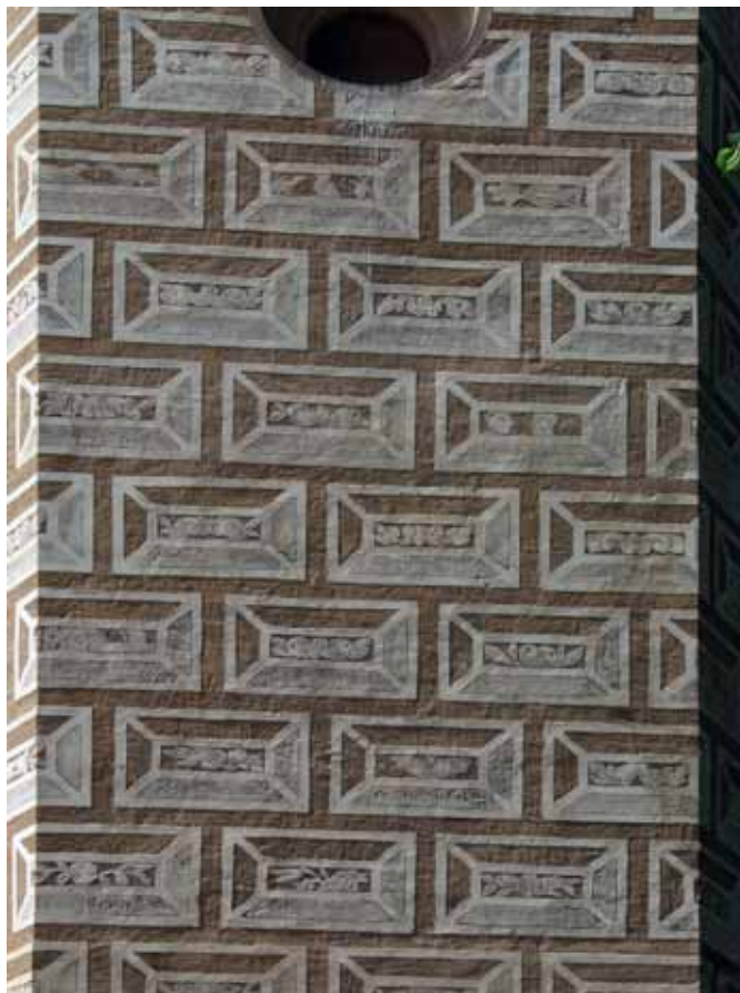
Obr. 51. Litomyšl, rekonstruované renesanční sgrafito. Úspěšné provedení finálních povrchových úprav (sgrafit či výmalby) se úzce váže k dobře zpracovanému základnímu povrchu omítkové plochy. (Foto P. Macek, 2001)
