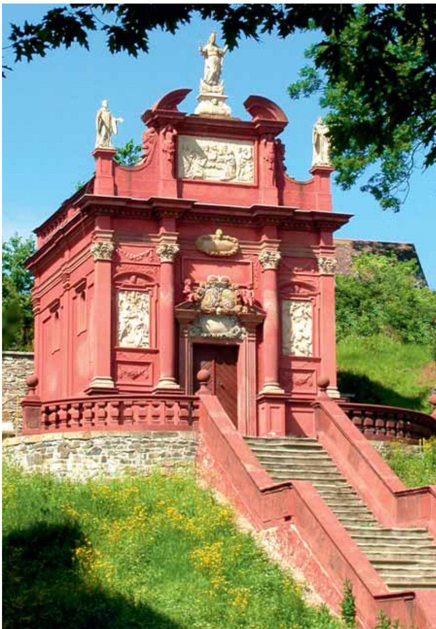
Obr. 43. Ostrov nad Ohří, barokní Einsiedelská kaple. K úplné tvarové i barevné rekonstrukci dochází spíše výjimečně. (Foto L. Zeman, 2004)
