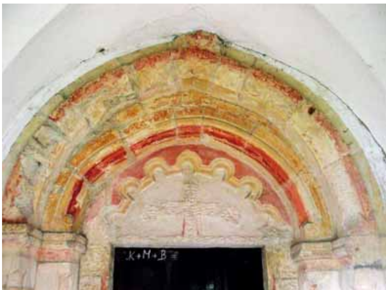
Obr. 6a. Libčeves, kostel Stětí sv. Jana Křtitele. Zažitý středověký přístup ovlivnil i obnovu románského portálu na přelomu gotiky a renesance. (Foto M. Patrný, 2003)
