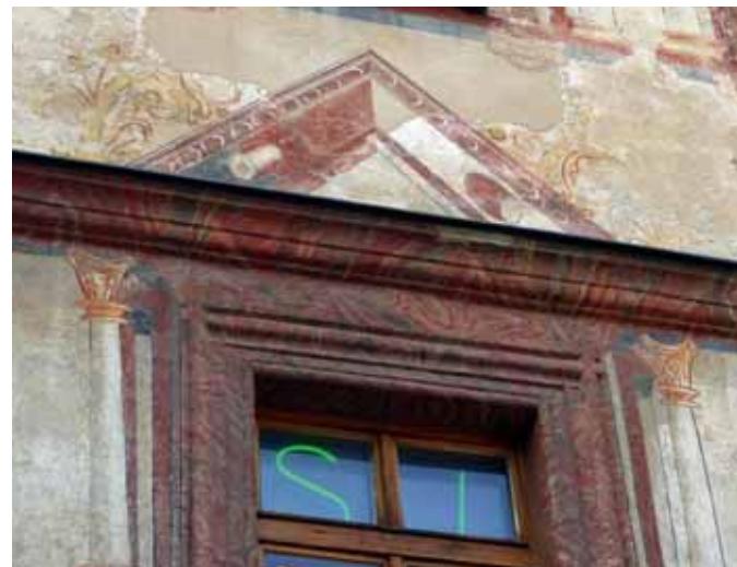
Obr. 10b. Jihlava, měšťanský dům na Masarykově náměstí. Při ztrátě malovaných iluzivních prvků působí plastické řešení nutně jako torzo, z výtvarného hlediska je navíc zcela odlišné od originálu. Ještě goticky profilované kamenné ostění je v tomto případě doplněno progresivní edikulou. (Foto P. Macek, 2005)
