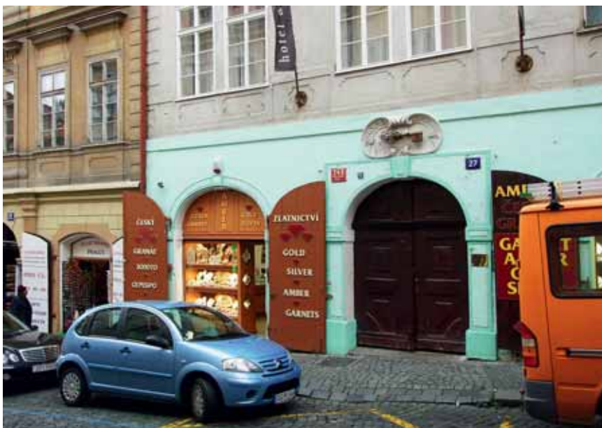
Obr. 54b. Praha, Malá Strana, čp. 243. Nešvarem s dlouhou historií je samostatně barvení určitého úseku fasády nezávisle na celku. (Foto P. Macek, 2009)
