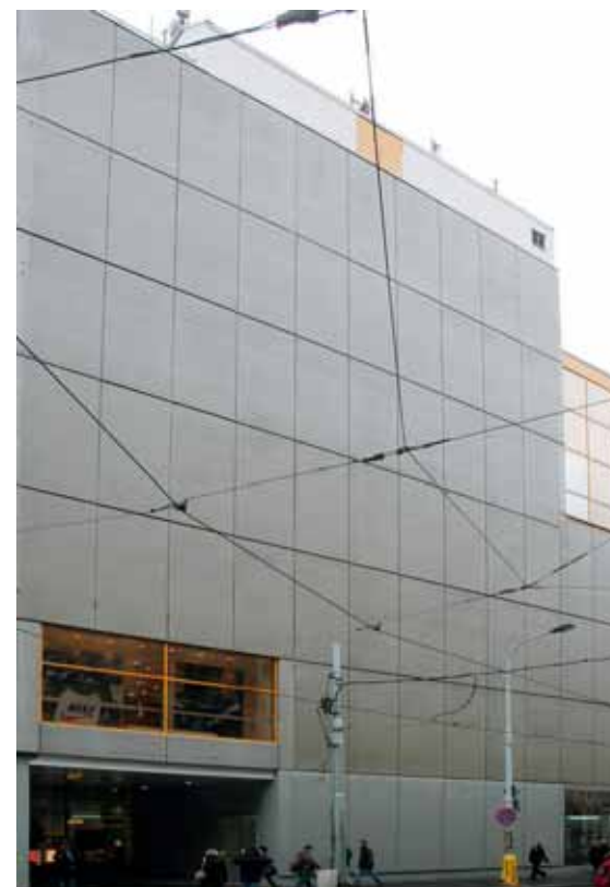
Obr. 23. Praha, Staré Město, bývalý obchodní dům Máj; J. Eisler, M. Masák, M. Rainiš, 1972–1973. Dramatické proměny stavebnictví ve druhé polovině 20. století s sebou přinesly mimo jiné i nové povrchy fasád s odpovídajícími barvami. Mimo pohledový beton byly používány i umělé hmoty, prosklené zavěšené stěny a řada dalších technologií i materiálů měnících podstatně výraz městského interiéru. (Foto M. Patrný, 2009)
