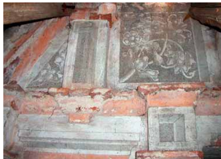
Obr. 33b. Telč, zámek, renesanční štít překrytý renesančním krovem. Zásadní objevy téměř narušených řešení lze nalézt na partiích průčelí zakrytých přístavbami. (Foto J. Bláha, 2009)
