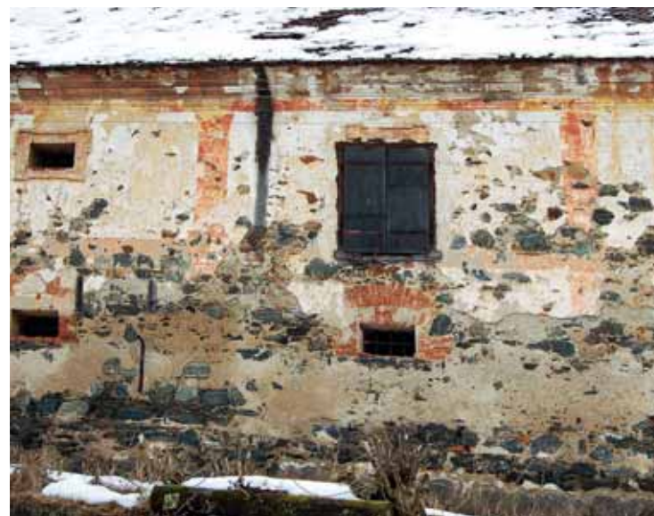
Obr. 33a. Žleby, barokní sýpka. Nálezová situace rychle mizí, což je způsobeno destrukcí povrchů. (Foto K. Kibic, 2005)
