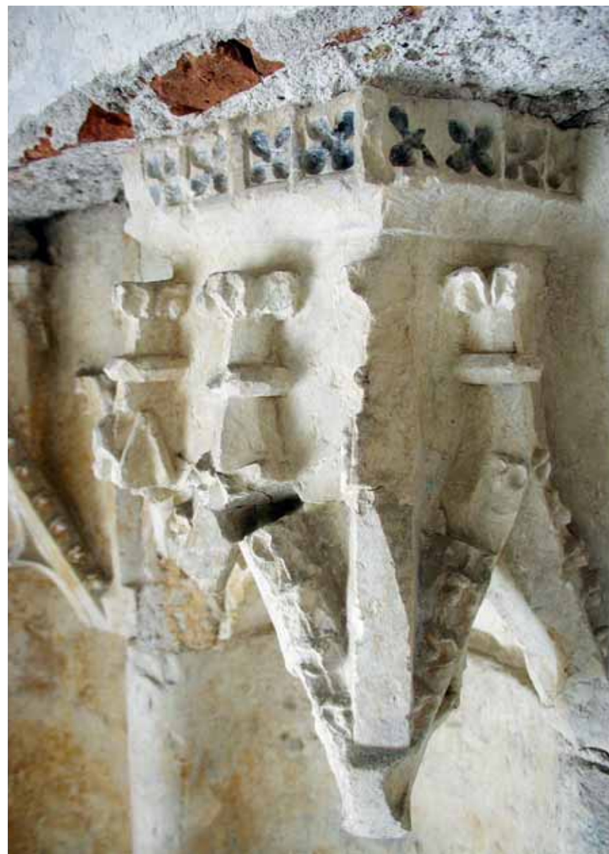
Obr. 7. Bílina, kostel sv. Petra a Pavla, baldachýn portálu kostela. Odlišné gotické řešení než znázorňují obrázky 6a, b. Je užit monochromní nátěr, v němž černá nahradila plasticky neprovedené prvky. (Foto J. Beránek, 2002)
