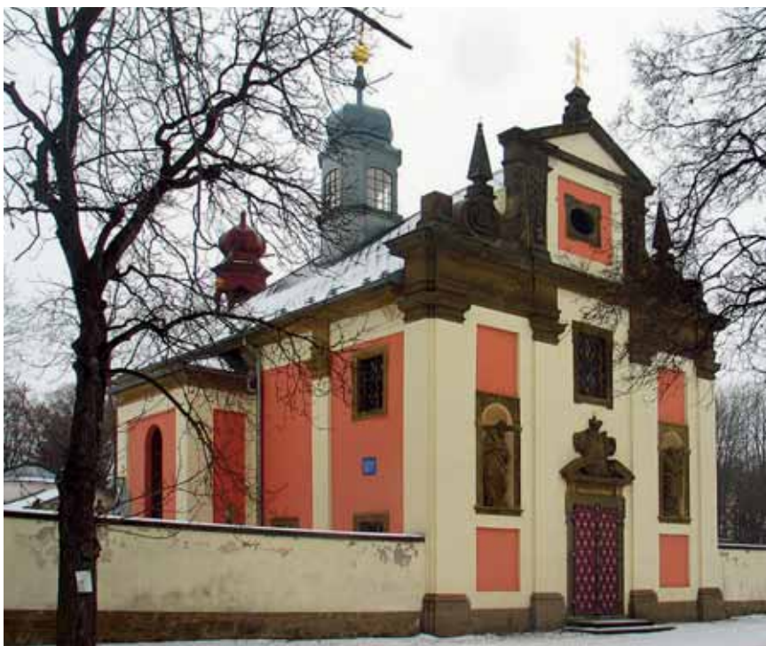
Obr. 46. Budenice, kostel sv. Isidora. Naprosto nevhodný přístup, dělíci fasádu na omítané části s rekonstruovanou barevností a uměle ztmavený, z kontextu zcela vytržený kámen. (Foto M. Patrný, 2005)
