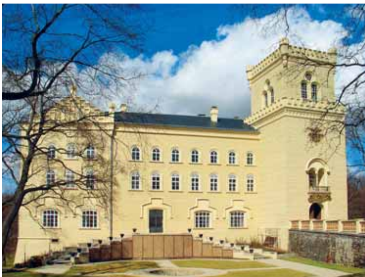
Obr. 16a. Chýše, zámek. V průběhu 19. století se postupně stále více používaly nátěry napodobující kamenné, případně cihelné zdivo. Rekonstrukce fasády z poloviny 19. století. (Foto M. Patrný, 2005)
