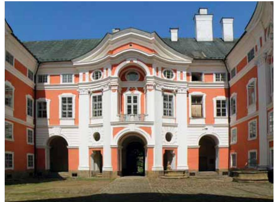
Obr. 13. Broumov, prelatura benediktinského kláštera; K. I. Dientzenhofer. Vrcholně barokní barevnost často rafinovaně transformovala starší řešení; v tomto případě bylo východiskem cihelné zdivo s osazenými kamennými články – takzvaná reverzní barevnost. (Foto M. Solař, 2005)
