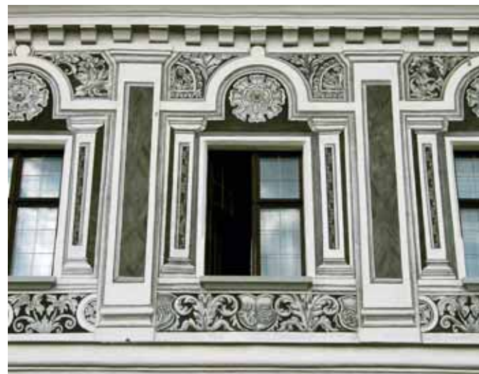
Obr. 10a. Telč, čp. 61. Náročnější renesanční sgrafito mělo patrně někdy malované doplňky. Nově restaurované průčelí s využitím mramorování, lesků a podobně. (Foto P. Macek, 2009)
