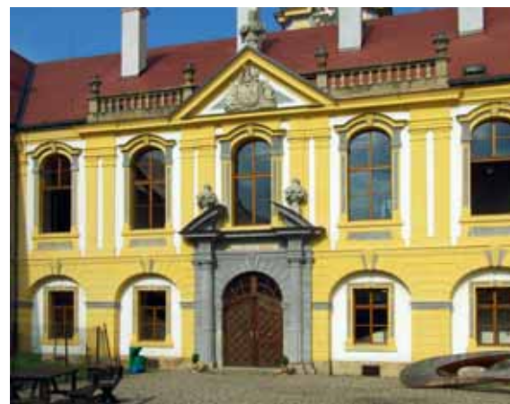
Obr. 14b. Děčín, zámek; J. J. Kosch. Odlišné, exaktně rekonstruované řešení prokázalo na sklonku 18. století inovaci starší tradice, zde navíc s barevným zdůrazněním historizujícího portálu. (Foto P. Macek, 2007)
