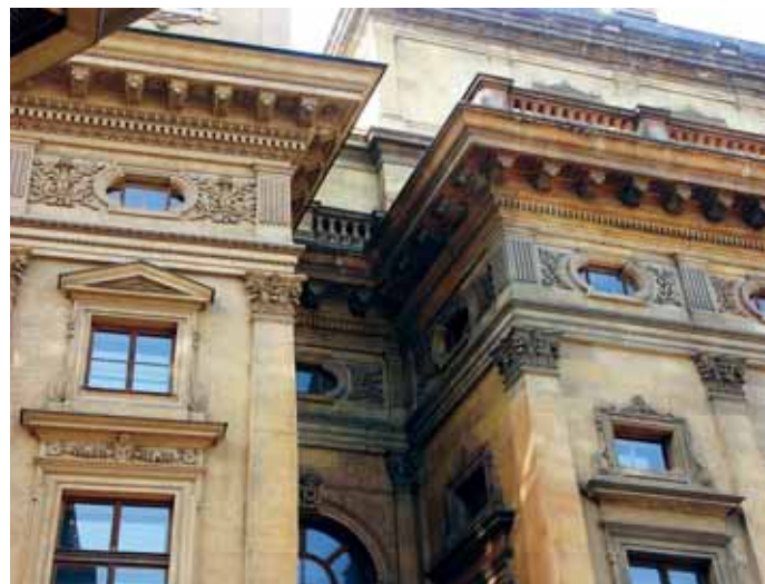
Obr. 17. Praha, Nové Město, Národní divadlo. Stejný přístup jako u předchozích obrázků, zde ze druhé poloviny 19. století, dokládá i tento příklad luxusnějšího provedení fasády, užívající v nižších úrovních kamenný obklad, výše kámen umělý a zcela nahoře již pouze malované iluzivní kvádrování. (Foto P. Macek, 2005)
