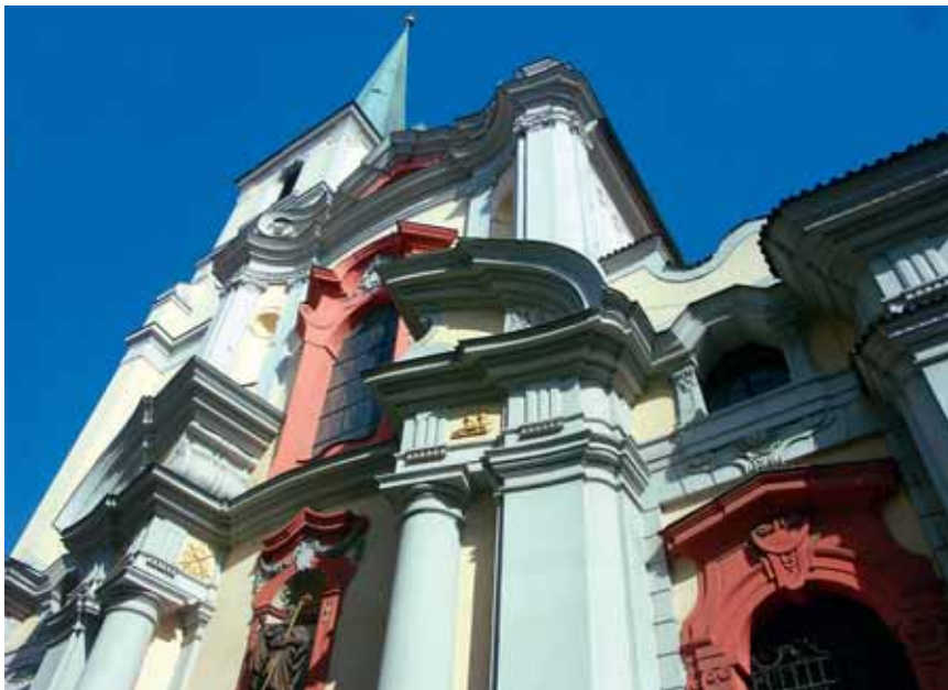
Obr. 2a. Praha, Malá Strana, kostel sv. Tomáše. Obecná představa o historické barevnosti je často spjata s kontrastním, nápadným řešením. Rekonstrukce vrcholně barokního průčelí kostela. (Foto P. Macek, 2003)
