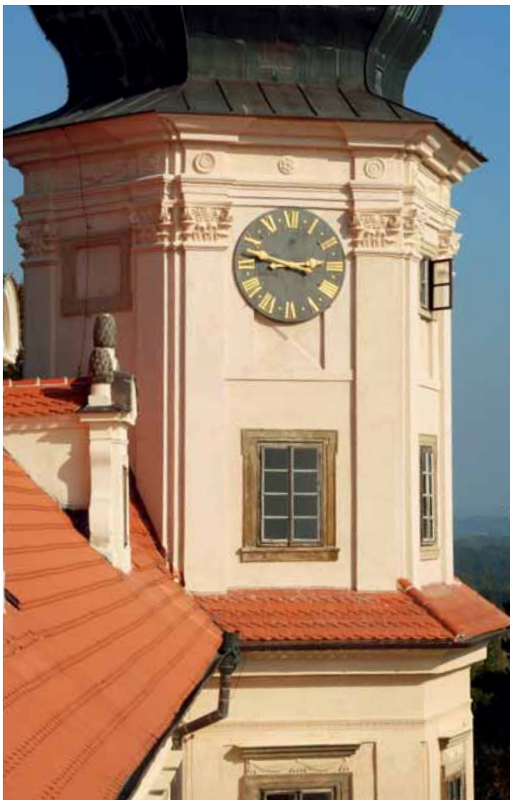
Obr. 56. Mníšek pod Brdy, zámek. V současné době jsou respektovány i některé donedávna striktně odmítané přístupy. Příkladem mohou být citlivě obnovené omítky s monochromním nátěrem a ponechanými kamennými prvky. Správně zde byla zohledněna poslední podstatná proměna objektu, k níž došlo na počátku 20. století. (Foto V. Láška, 2008)
