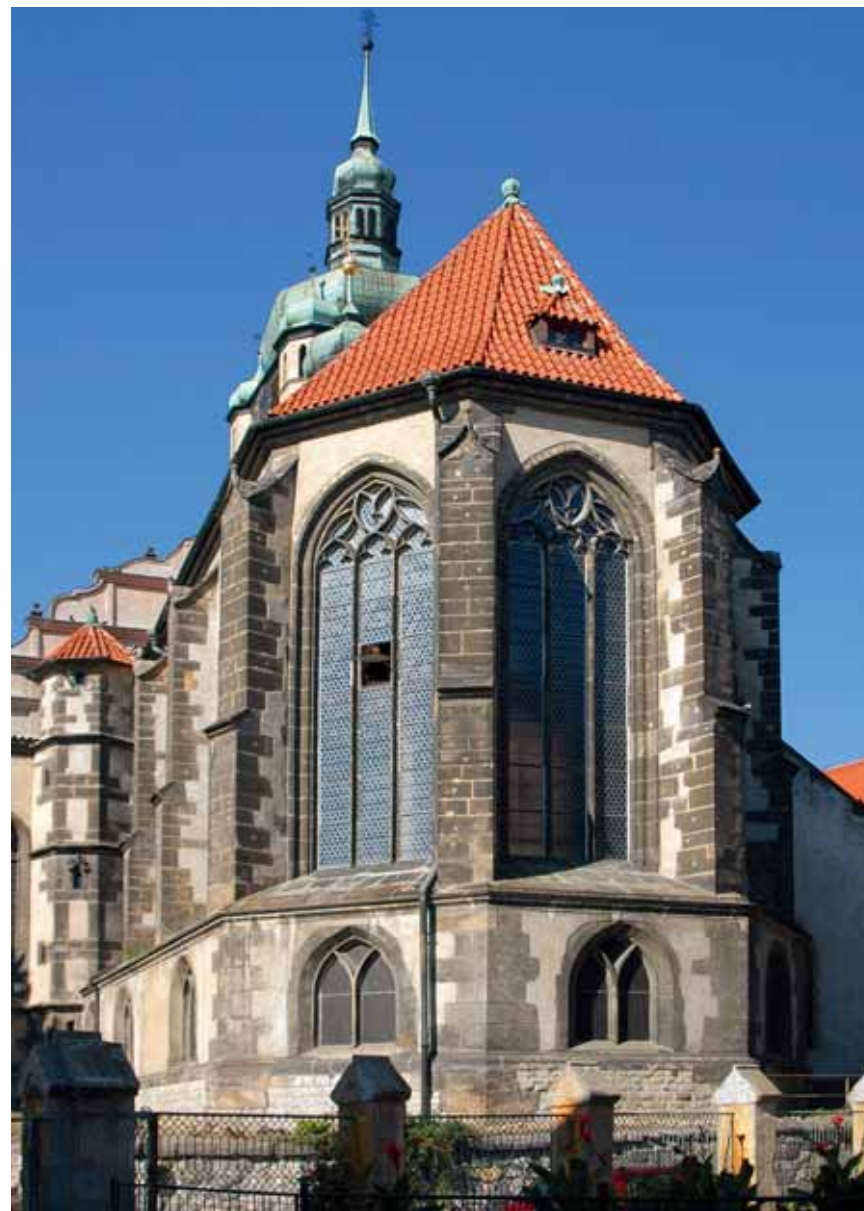
Obr. 45. Mělník, proboštský kostel sv. Petra a Pavla. V podstatě materiálová barevnost respektující patinu na kamenných prvcích zdůrazňuje malebnost na úkor tvaru (vztah armovacích kvádrů k obílené omítce). (Foto P. Macek, 2001)
