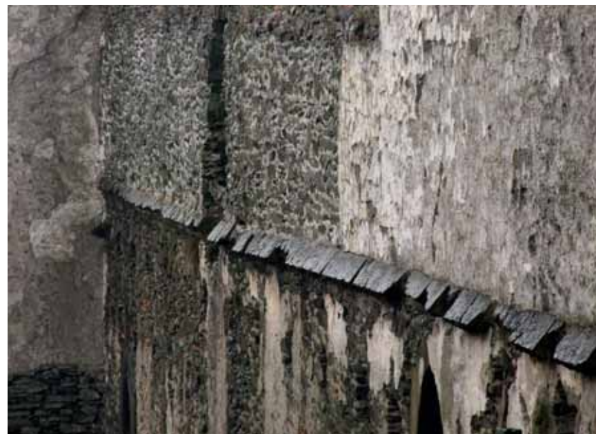
Obr. 34. Bezděz, hrad, severní průčelí paláce s doklady zaniklých dřevěných konstrukcí. Vyhodnocení průzkumů nepřináší pouze zprávu o barevném řešení, ale také o řadě dalších skutečností. (Foto P. Macek, 2005)
