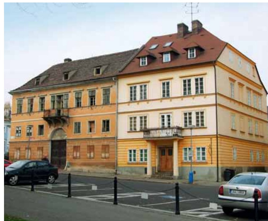
Obr. 3. Teplice v Čechách, čp. 214, 215. Vliv zvolené barevnosti lze doložit na dvojici klasicistních domů; vlevo stav z 80. let 20. století, vpravo nedávná razantní obnova. (Foto P. Macek, 2009)
