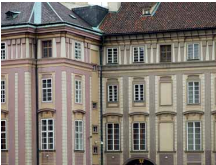
Obr. 48a. Praha, Hradčany, Pražský hrad, fasády třetího nádvoří. Problémy někdy způsobuje opakovaná obnova shodně barvených částí, negativní vliv na výsledek může mít změna barvy starší části či barevné odchyly nové barvy, případně neustálá snaha o estetické „vyladění“. (Foto P. Macek, 2009)
