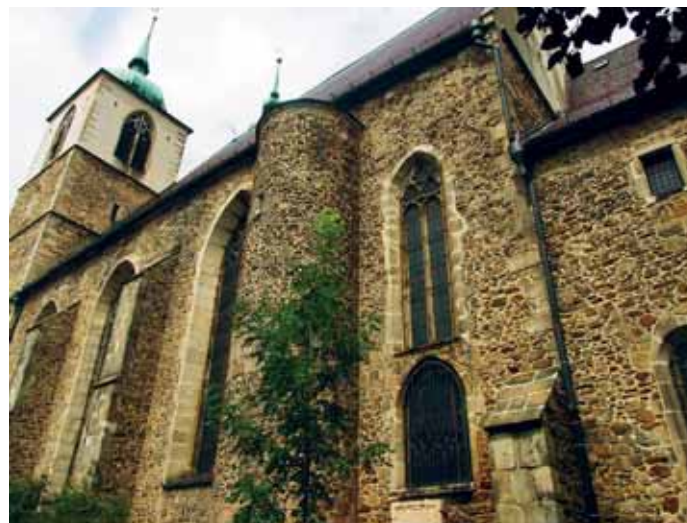
Obr. 18. Jihlava, farní kostel sv. Jakuba. Spolu s romantickým přístupem a zejména následnou puristickou metodou získala na oblibě kamenná stěna, zbavená (i násilně) starších omítkových i nátěrových vrstev. (Foto P. Macek, 2008)
