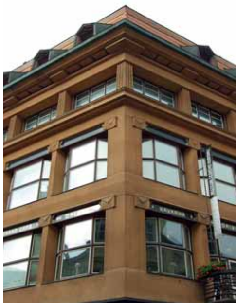
Obr. 20a. Praha, Staré Město, dům U Černé Matky boží; J. Gočár, 1911–1912. V období kubismu byly preferovány monochromní nátěry zvýrazňující plasticitu průčelí (tvrdé omítky s charakterem umělého kamene). (Foto P. Macek, 2009)
