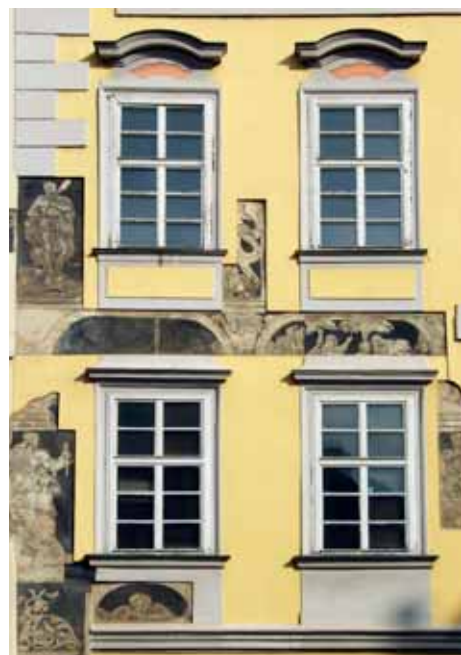
Obr. 26a. Praha, Staré Město, dům čp. 3. Nové trendy v památkové péči zasáhly i do podoby fasád. Na fotografii je příklad průhledu do historicky odlišné vrstvy při uplatnění analytické metody. (Foto P. Macek, 2009)
