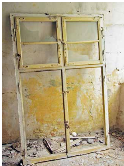
Obr. 10: Některá vysazená okenní nebo dveřní křídla mohou být zachována v interiéru budovy (Toužim – okres Karlovy Vary, zámek; foto A. Schubert, 2010).
